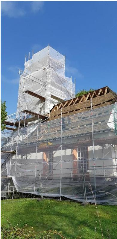
Schiefer und Schalung wurden von der Holzkonstruktion abgenommen. Dabei wurden kleinere Schäden an der Holzkonstruktion des Schiffs und etwas größere Schäden am Turm erkennbar. Die Schäden entsprechen in etwa dem erwarteten Umfang.
